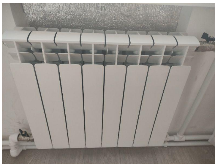
1.9-сурет – “Rifar Base 500” радиаторының орналасуы
